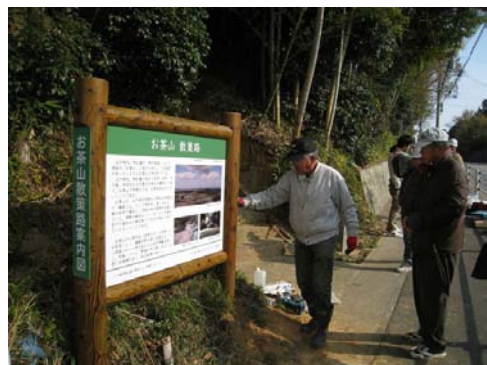
●看板設置作業の様子
